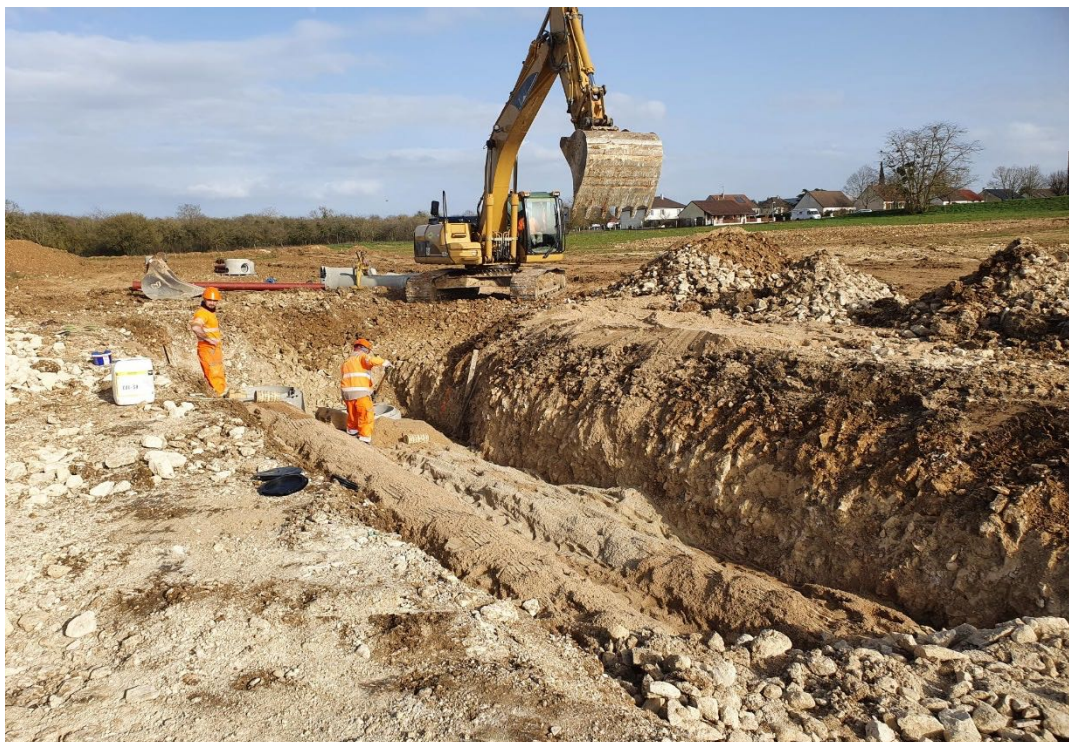
Travaux en cours
